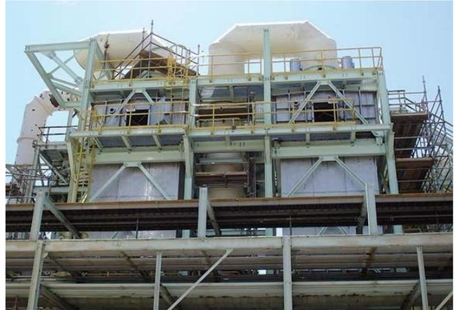
Reemplazo ESP húmedo de aleación B&W para unidades de niebla ácida de plomo.
